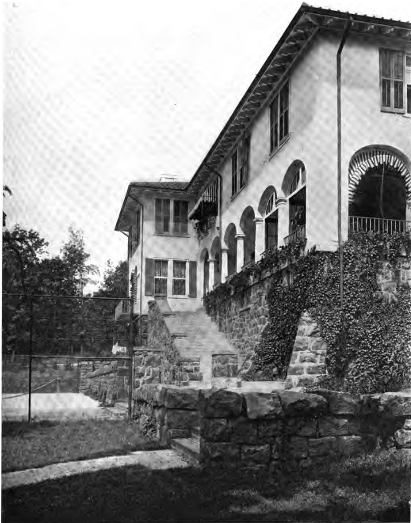
RESIDENCE OF MR. B. F. REINMUND, ENGLEWOOD, N. J.
